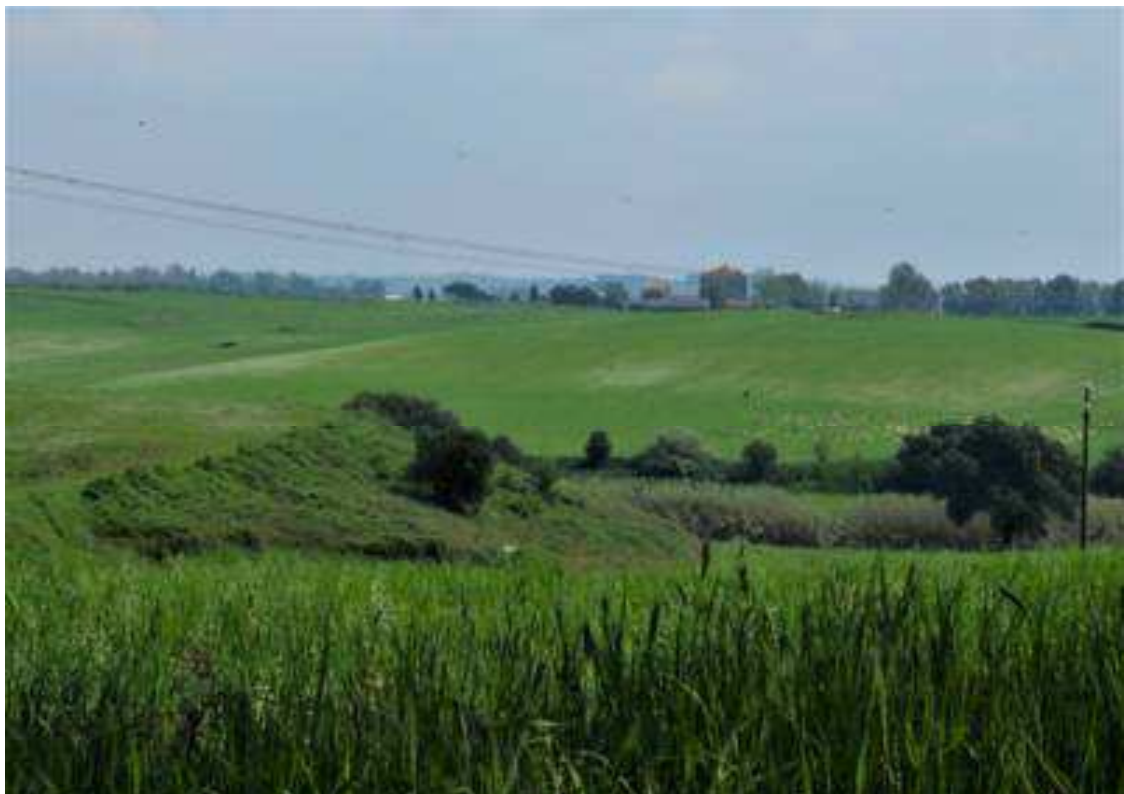
Fig. 77 Il casale di Valle Caia (num. 41), antico maniero seicentesco visto da Nord da via della Siderurgia, oltre il corso del fosso di Santa Palomba.
