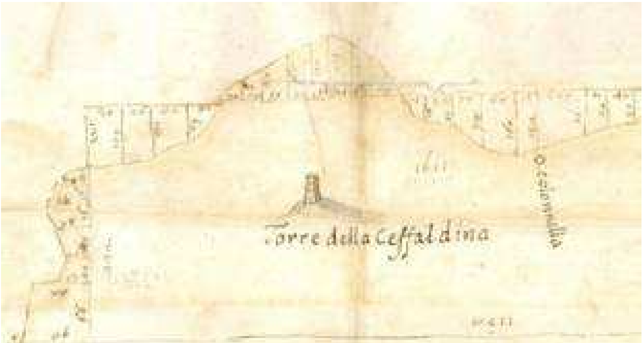
Fig. 4 Particolare della tavola del Catasto Alessandrino num. 433A/45 del 1660 con la rappresentazione di Torre della Ceffaldina indicata come “Torre della Ceffaldina”. Oggi la torre si presenta come un insieme di blocchi in opera a tufelli crollati seppure visibili ancora in situ.
