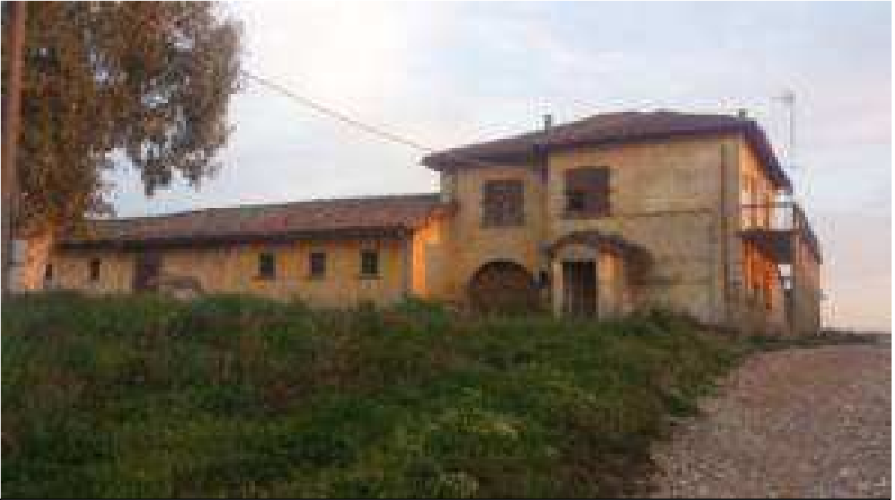
Fig. 100 Il casale O.N.C. 2872 (num. 114) realizzato ai tempi della bonifica fascista lungo via della Pescarella.
