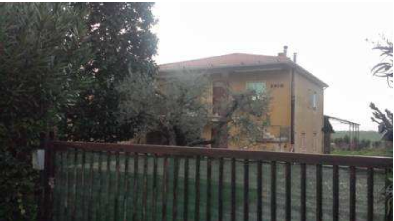
Fig. 121 Il casale O.N.C. 2810, vista frontale da via dell’Incastrino.
