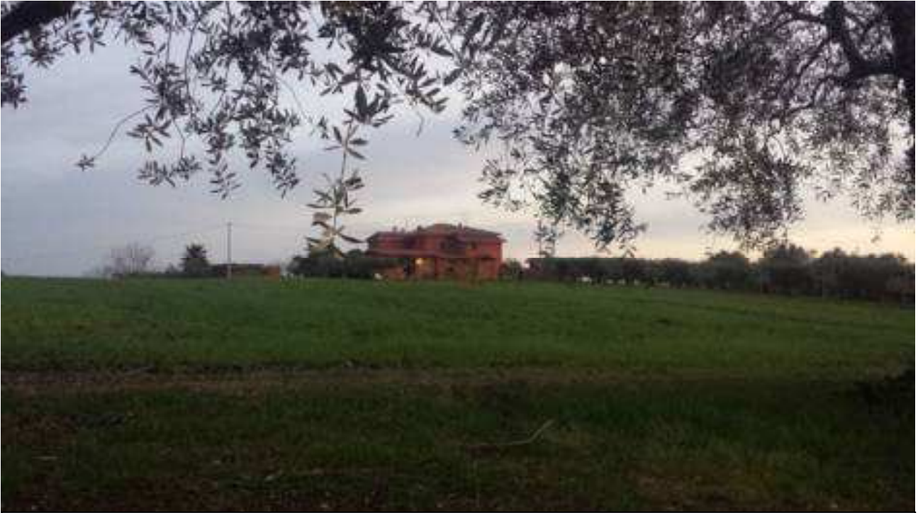
Fig. 120 Il casale O.N.C. 2811, vista frontale da via dell’Incastrino.
