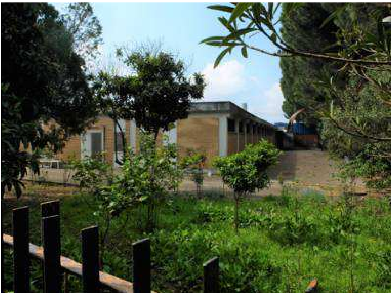
Fig. 35 Edificio limitrofo al complesso di Torre Maggiore (num. 56), ubicato nel lotto a Sud di quest'ultima.
