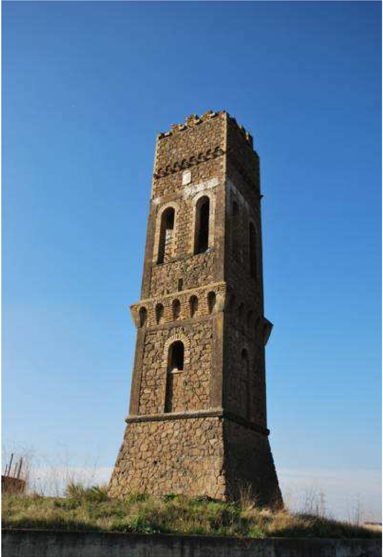
Fig. 53 Torre Fausta (num. 55) riserva d'acqua edificata nel 1927 dal proprietario terriero conte Giovanni Ticca. Si scorge nel corpo murario il blasone dalla famiglia Ticca.
