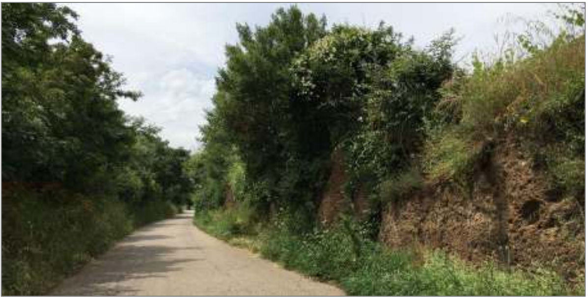
Fig. 78 Tagliata di strada Freddano
