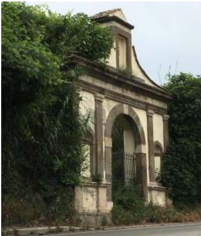
Fig. 31 Strada Bagni, portale di ingresso a un podere
