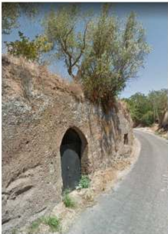
Fig. 126 Strada del Salamaro, dettaglio della tagliata
