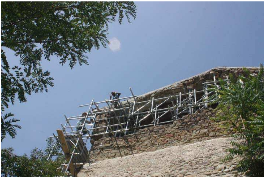
Il montaggio della struttura di protezione nella zona posteriore.
