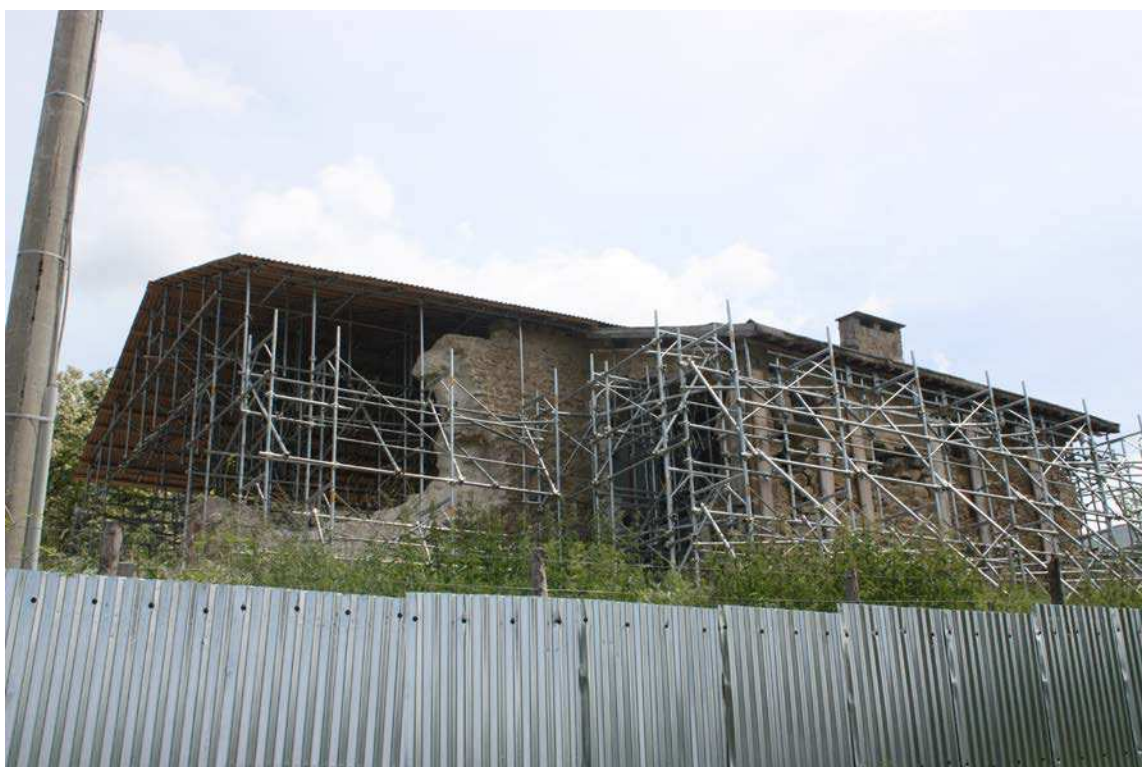
Vista del fianco destro a fine cantiere.
