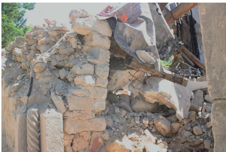
Dettaglio dell'ingresso all'inizio dei lavori.
