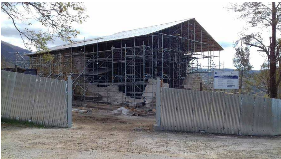
L'ingresso e il fianco sinistro a fine cantiere.
