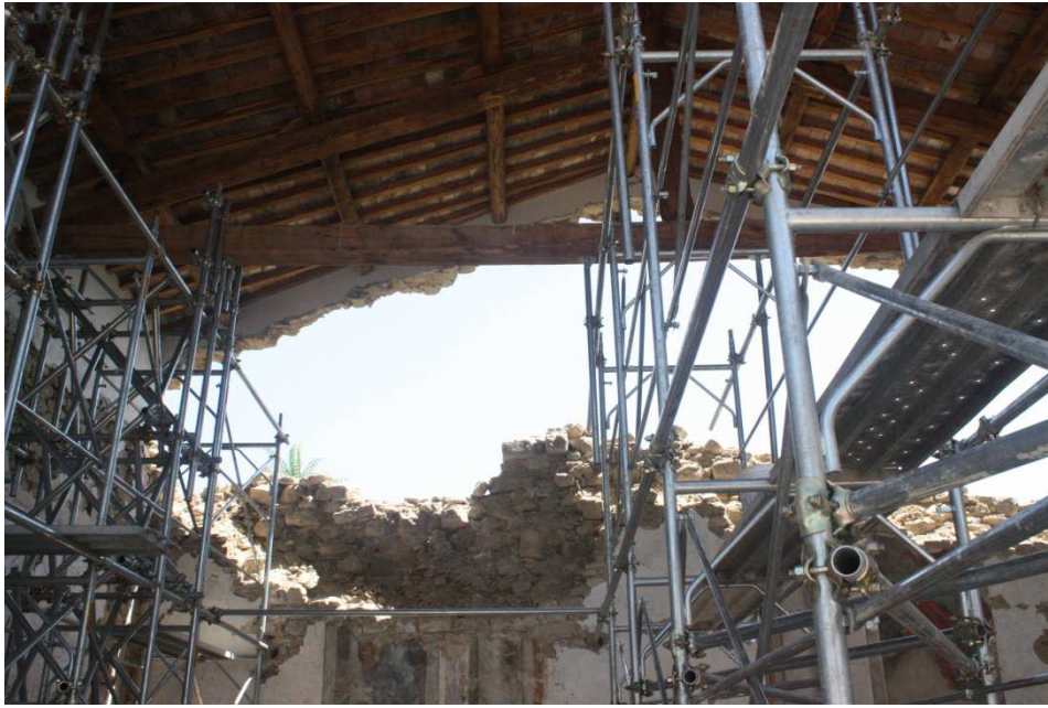
Dettaglio della struttura di sostegno nella zona di fondo della chiesa.
