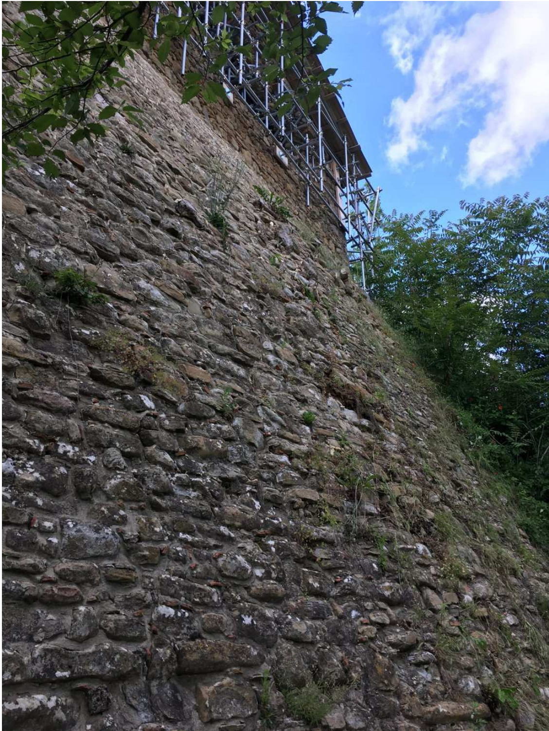
Lo sperone su cui poggia la chiesa posteriormente.
