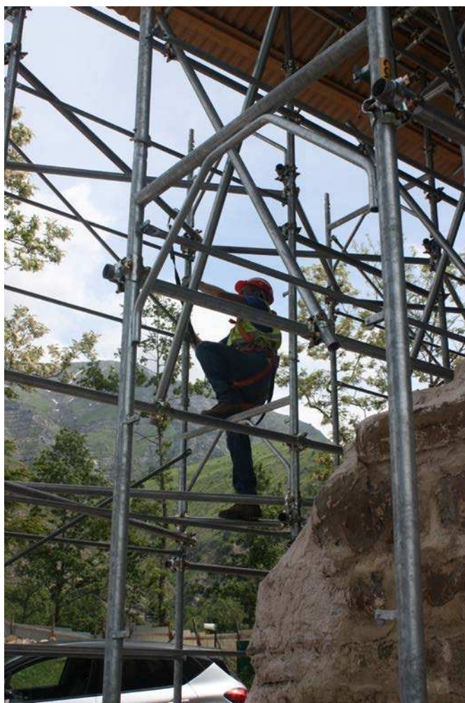
La costruzione dell'opera provvisoria sul fianco sinistro.
