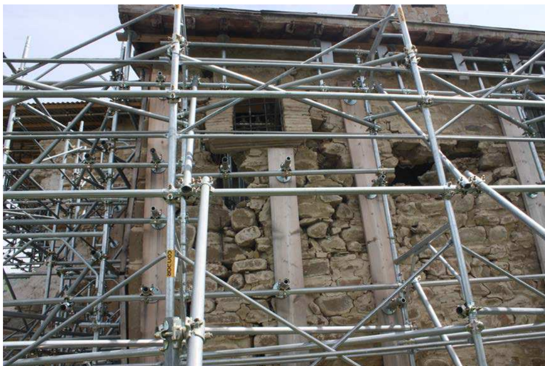
Dettaglio della struttura provvisoria all'esterno della canonica.
