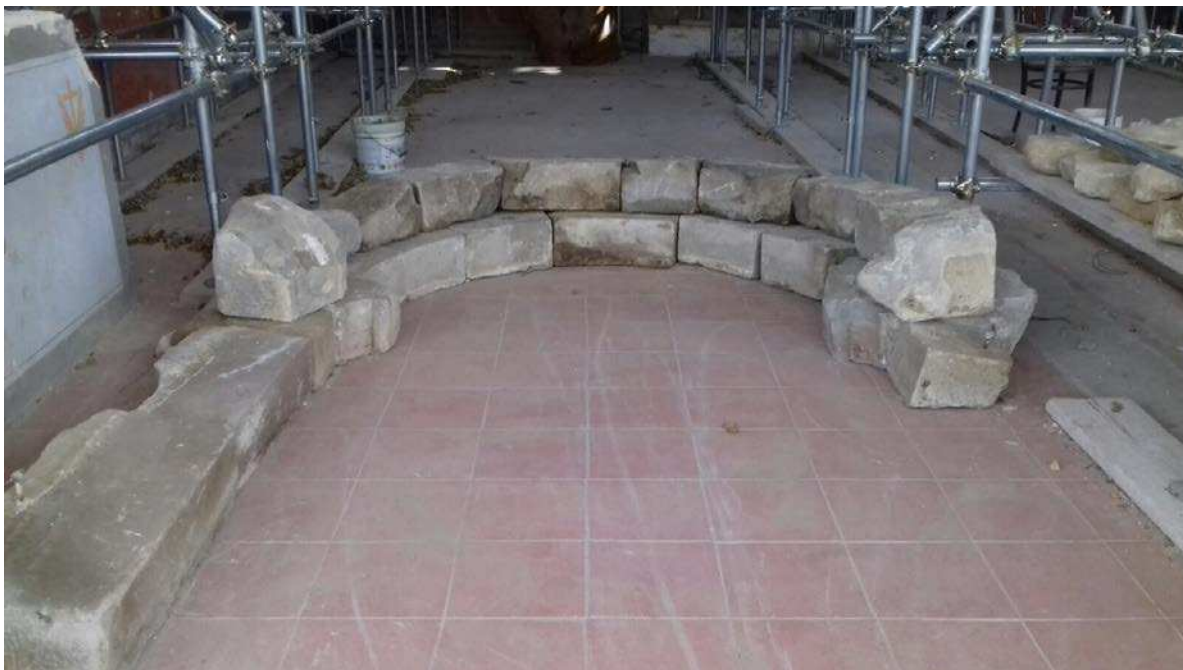
Prova a terra di ricostruzione del portale.
