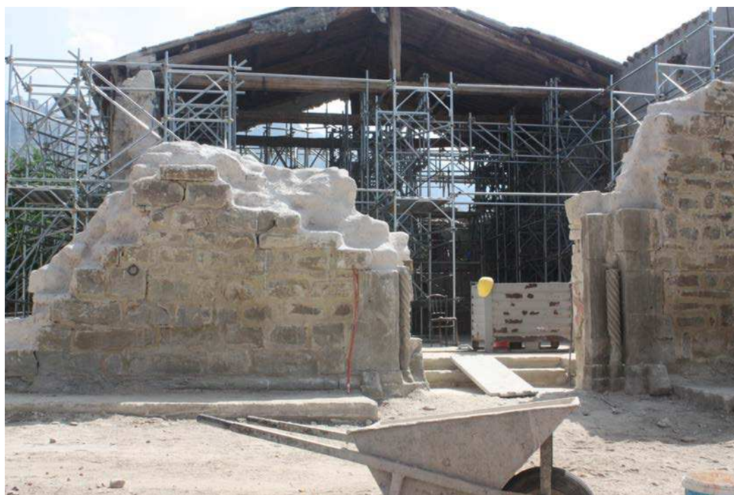
Particolare dell'ingresso prima della costruzione della tettoia di copertura.
