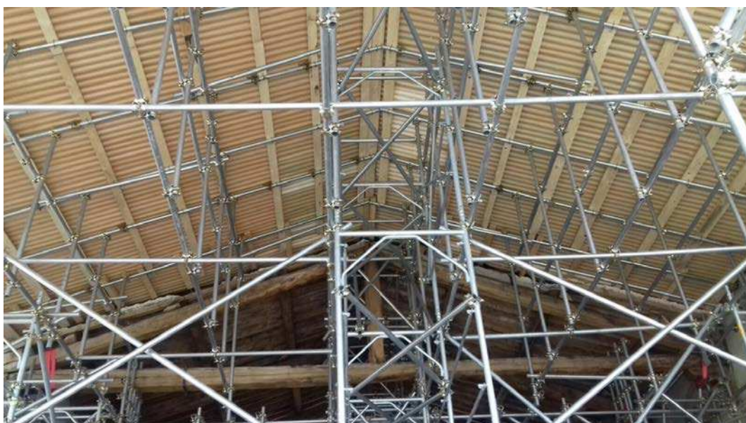
Dettaglio della copertura che mostra il raccordo con la tettoia provvisoria.
