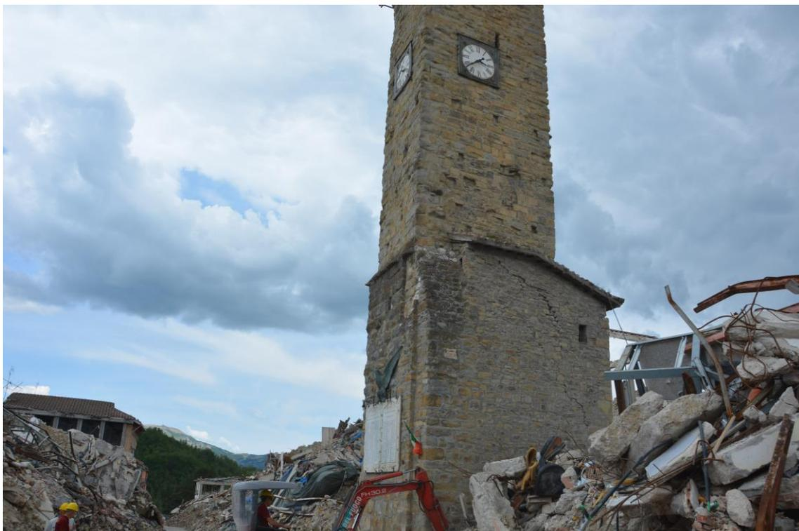
Foto 1) Amatrice (RI), l'entità del danno a seguito del sisma del 24 agosto 2016, (Foto dell'autore).
