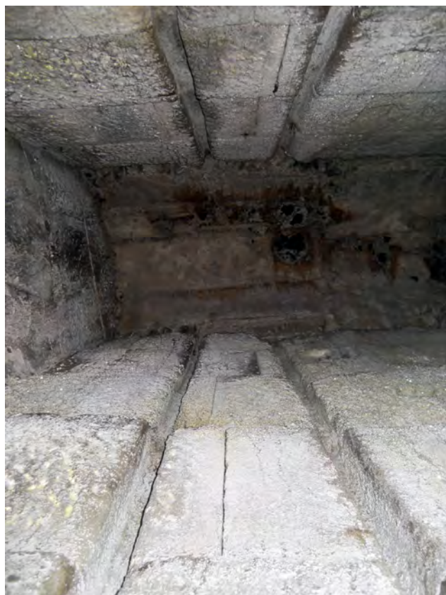
Fig. 8. Scanalature per l'alloggiamento delle paratie.
