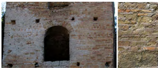
Fig. 4. Particolare della tecnica muraria in opera listata con specchiature in opera reticolata; particolare della stilatura dei giunti di malta.
