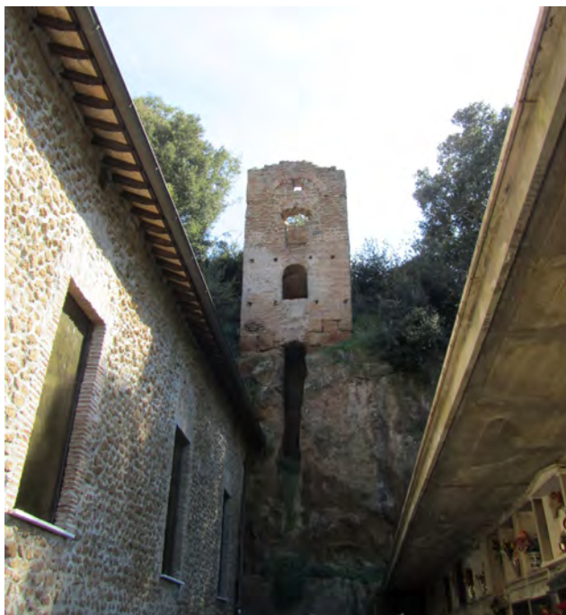
Fig. 2. La struttura turrata in rapporto alla chiesa di S. Marina.
