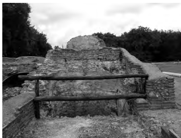
Fig. 4. Veduta da sud dell'ambiente n. 34. Sul muro di fondo si riconoscono tracce della pavimentazione originaria.
