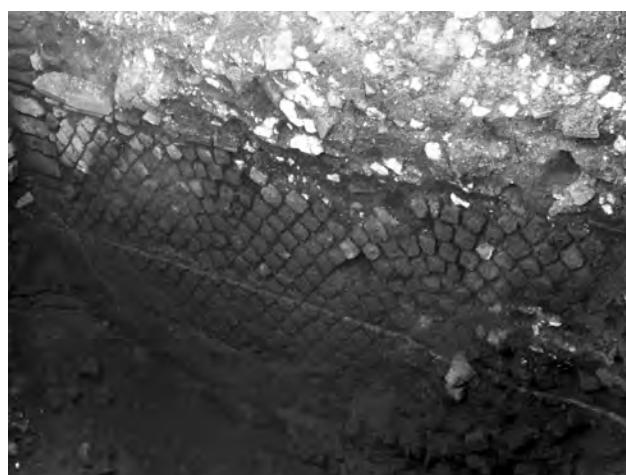
Fig. 9. Colleferro, Fontana degli Angeli. Cisterna ipogea.
