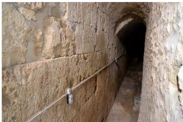
Fig. 4. Galleria sotterranea addossata alla parete settentrionale della Cattedrale: a sinistra il muro in opera quadrata del tempio, in basso le lastre di calcare a copertura del basamento.
