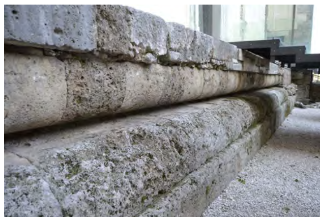
Fig. 3. Il podio del tempio sul lato occidentale della Cattedrale.
