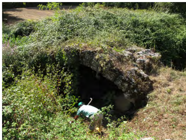
Fig. 4. Il ponte prima dell'intervento.
