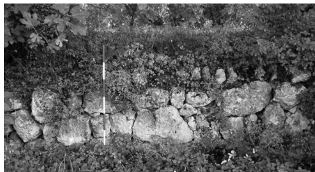
Fig. 4. sostruzione in opera poligonale in loc. Madonna di Loreto a Castrocielo.
