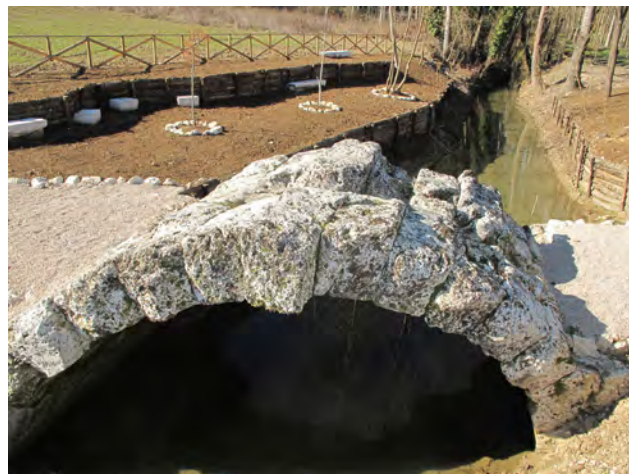
Fig. 5. Il ponte dopo l'intervento.
