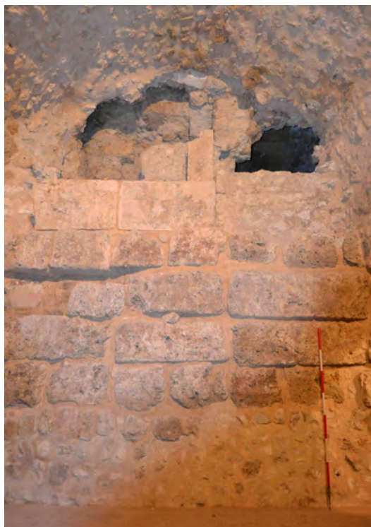
Fig. 6. Ambiente sotto la scalinata d'ingresso alla Cattedrale con i resti di una struttura muraria in opera quadrata (dopo il restauro).
