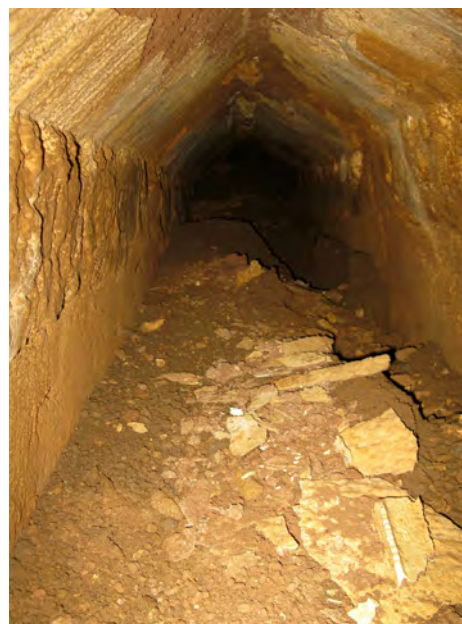
Fig. 7. Particolare dell'interno del condotto del settore C.
