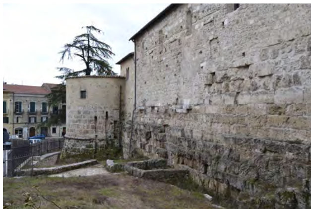
Fig. 5. Muro in opera quadrata del tempio sul lato orientale della Cattedrale, in fondo il torrione aragonese.
