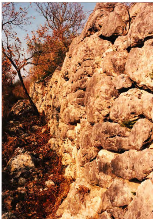
Fig. 8. S. Elia Fiume Rapido. Loc. Costa Lunga, tratto di mura (foto L. Caira).
