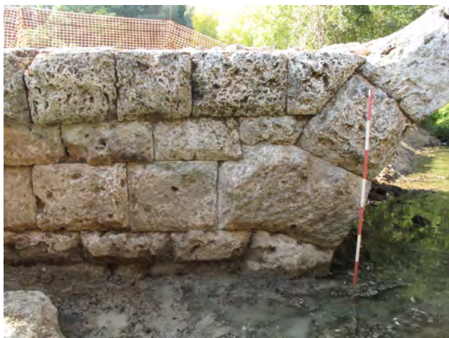
Fig. 7. Particolare del concio calettato sul prospetto sud.
