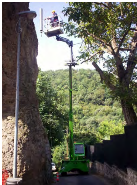
Fig. 4. Strada dei Ruderì Romani, interventi di messa in sicurezza.
