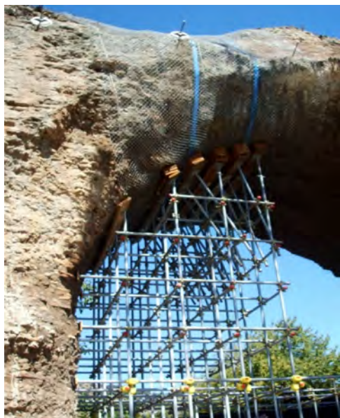
Fig. 3. Imbracature, puntellamenti e incatenamento dello speco del 1° arco.
