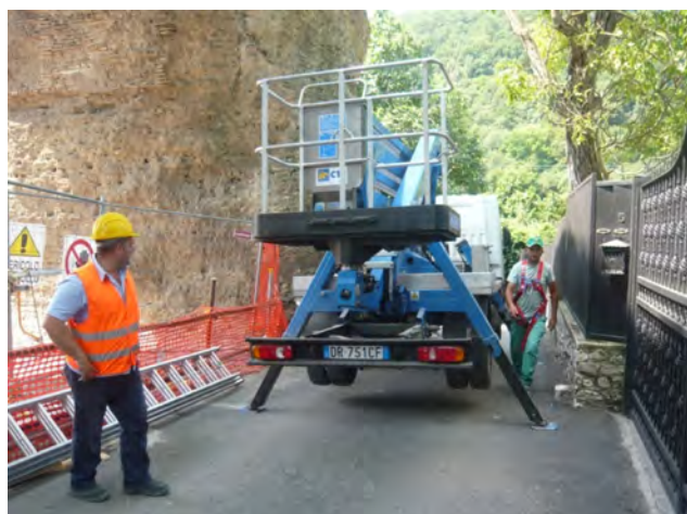
Fig. 6. Il cantiere - Aspetti tecnico-organizzativi.
