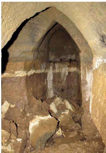
Fig. 4. Camera di captazione.
