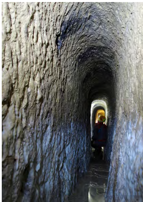
Fig. 9. Acquedotto di Fonte Cantaro: cunicolo principale.
