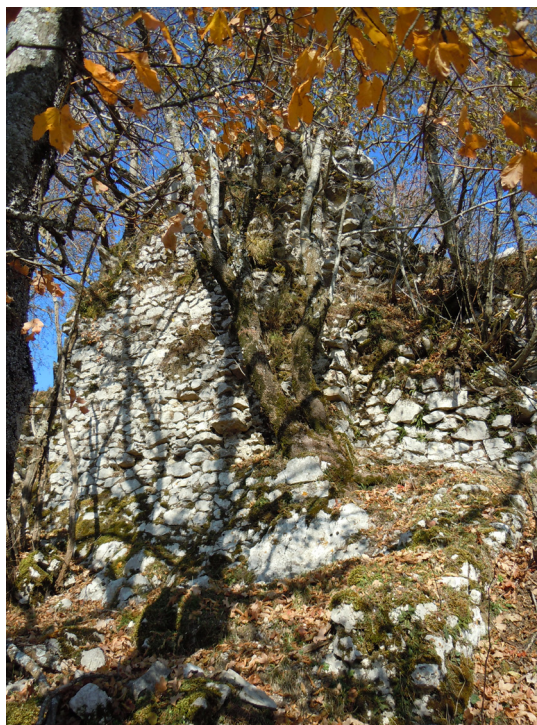
Fig. 6. Torre della rocca di Spogna, realizzata con bozze irregolari senza corsi orizzontali, riferibile a una prima fase d'incastellamento del sito (foto M. Bernardi).
