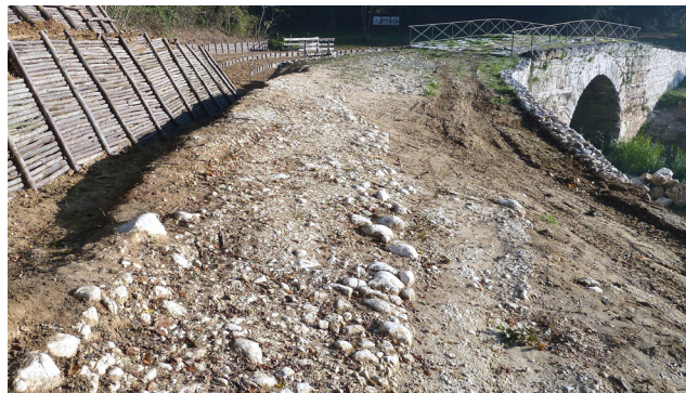
Fig. 9. Roviano, Forma di Testa: la via Valeria a ovest del ponte.
