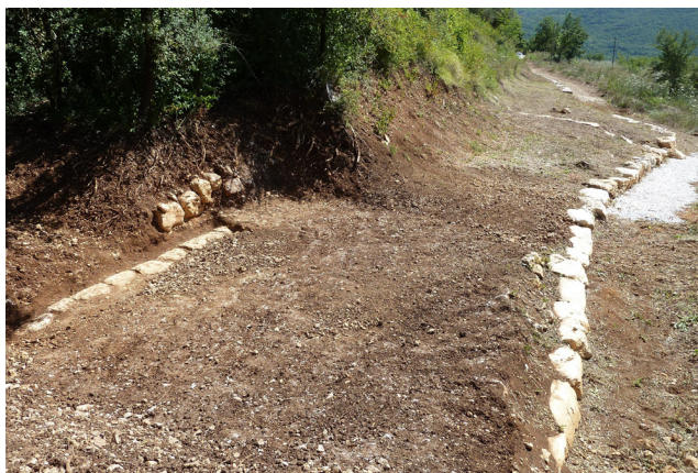
Fig. 3. Roviano, via Tiburtina Valeria, km 56: via Valeria, tratto scavato (vista da quota inferiore).
