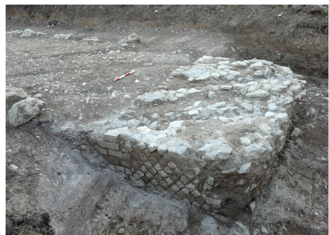
Fig. 5. Castel Madama: spalla del ponte.
