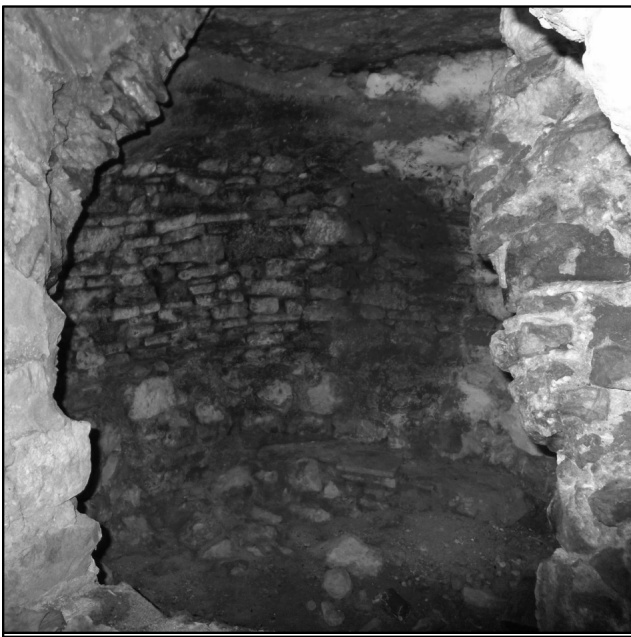
Fig. 2. Immagine di dettaglio dell'ambiente risparmiato entro il volume della sostruzione della prima terrazza.
