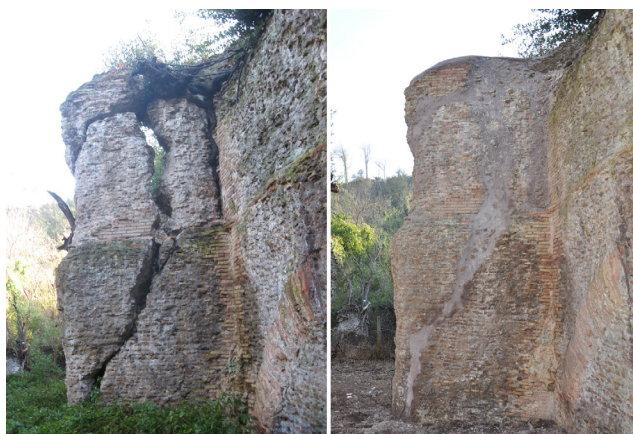
Fig. 9. Ponte Diruto: Anio Novus, il contrafforte prima (a sinistra) e dopo (a destra) l'intervento di consolidamento.
