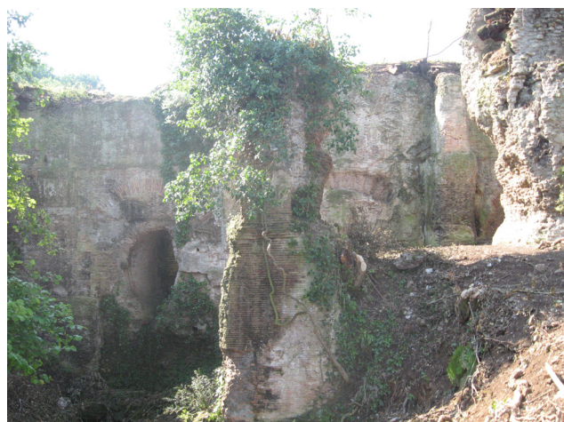
Fig. 4. Ponte Diruto, Anio Novus, tratto in corrispondenza del Fosso dell'Acquatrasversa.
