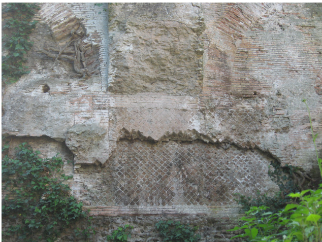
Fig. 5. Ponte Diruto, Anio Novus, particolare delle diverse sovrapposizioni del paramento.
