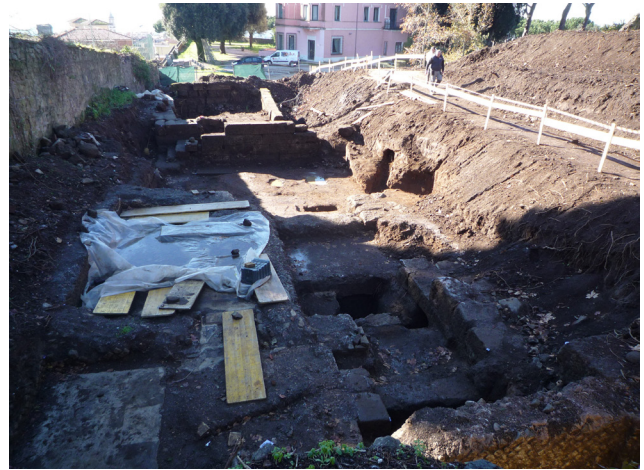
Fig. 7. Panoramica dell'area di scavo da nord-est; sulla sinistra sono l'ambiente A VII e A VIII, sulla destra gli ambienti A III, A IV, A V e, sul fondo, gli ambienti A II e A I (pilone).
