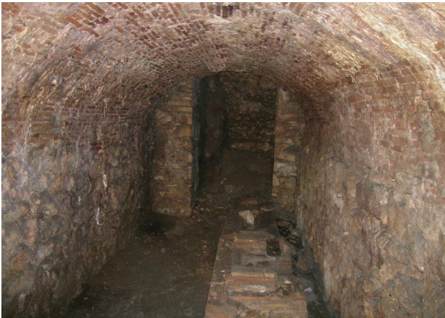
Fig. 5. Palazzo Aluffi (Rieti), ambienti sotterranei del palazzo sotto la quota pavimentale romana.
