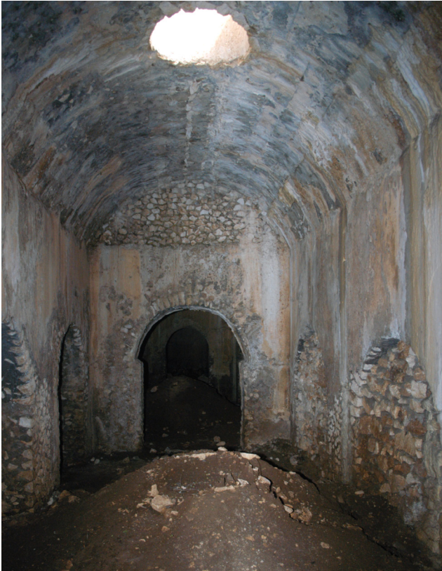
Fig. 2. Marcellina, via Principe di Piemonte: navata della cisterna.
