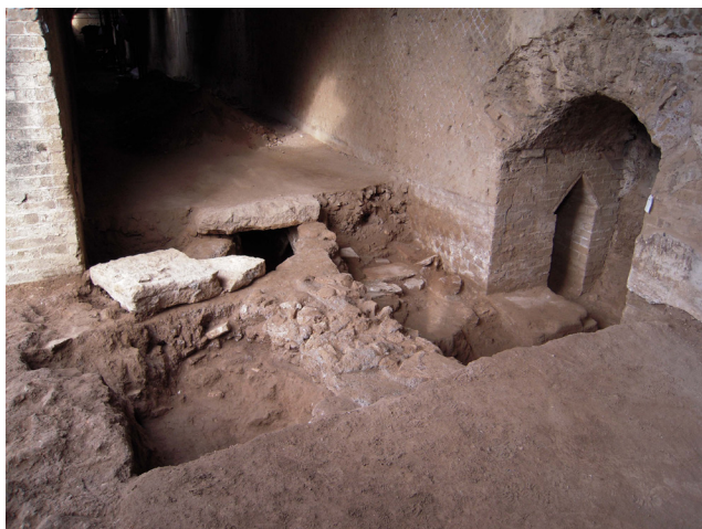
Fig. 3. Criptoportico delle Grandi Terme: posizionamento del condotto di scarico, in corrispondenza dell'uscita dalla galleria, dove è ubicato il punto di raccordo dei cunicoli di scarico provenienti dalla zona meridionale.
