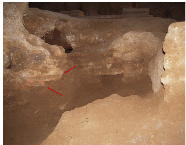
Fig. 2. Criptoportico delle Grandi Terme: tracce di fistulae con andamento nord-sud nell'incrostazione calcarea al di sotto del livello pavimentale della galleria.
