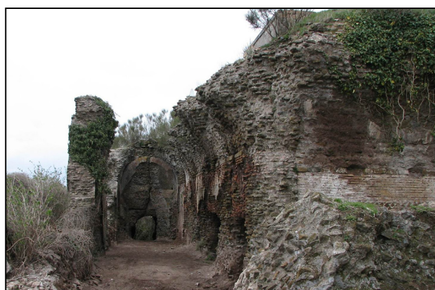
Fig. 1. Veduta del corridoio centrale delle sostruzioni del Santuario extraurbano, da sud.
